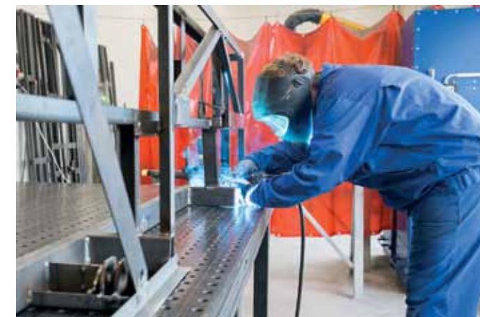
Při přestavbě nás totiž vždy čekají velmi kvalifikované úkoly, na které potřebujeme dostatečný čas a především zručné a velmi zkušené pracovníky
