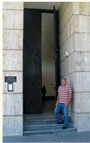
Vstupné dvere do budovy sú vysoké takmer šesť metrov a okrem zložitej manipulácie spôsobujú v chladnejších mesiacoch únik tepla.
