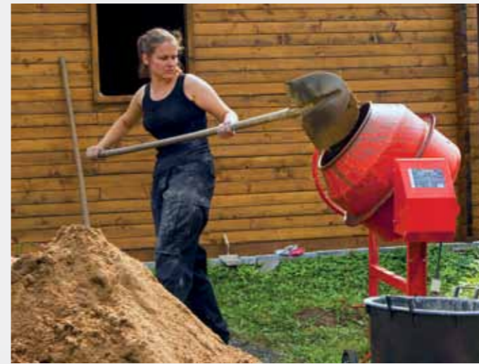
...úspěchy lze spatřit ve vzniku profesních kvalifikací – hrobník, stavitel podzemní hrobky - zkoušky z profese (stavitel hrobky), foto Pavel Ondera
