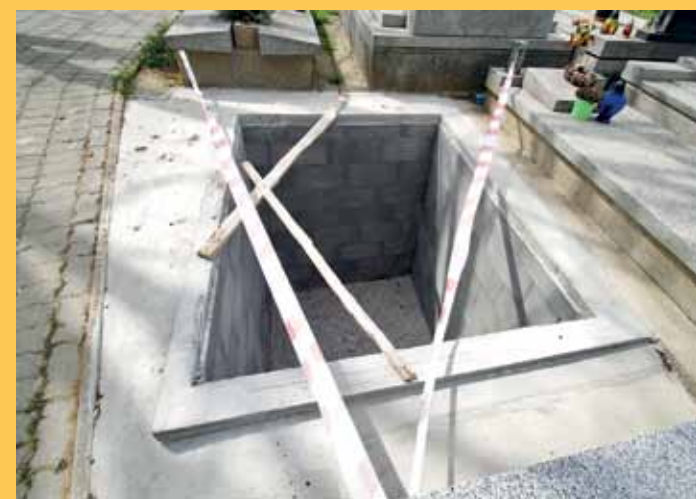
Stavba hrobky musí spĺňať nielen hygienické ale aj stavebné podmienky (cintorín Hlohovec, foto Pavel Ondera)
