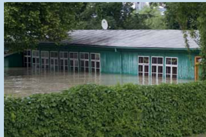
Tá istá budova počas povodne. Výška hladiny sa zdvihla na úroveň 100 ročnej vody. Dosiahla bez mála 10 a pol metra. Foto Pavel Ondera 5. 6. 2013
