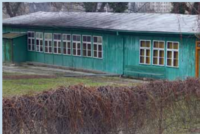
Záplavová časť, budova je od Dunaja cca 60 metrov. Výška jeho hladiny v normálnej kolíže okolo hranice troch metrov. Foto Pavel Ondera 26. 12. 2013
