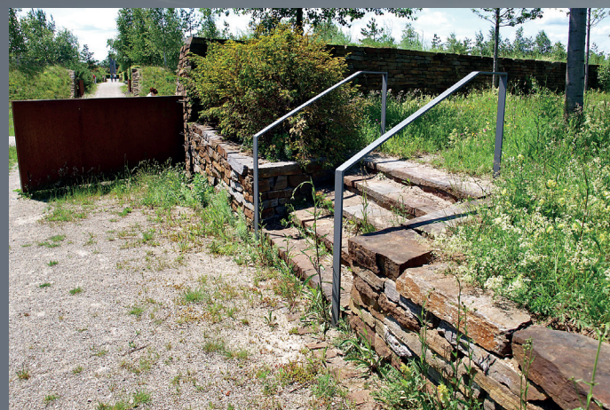
Vstupy do hrobových polí sú riešené kovovými bránami a rozdiely terénov sú preklenuté kamennými suchými múrikmi. Vľavo dole hrobové polia s radmi hrobov. (Halajová, 2009)
